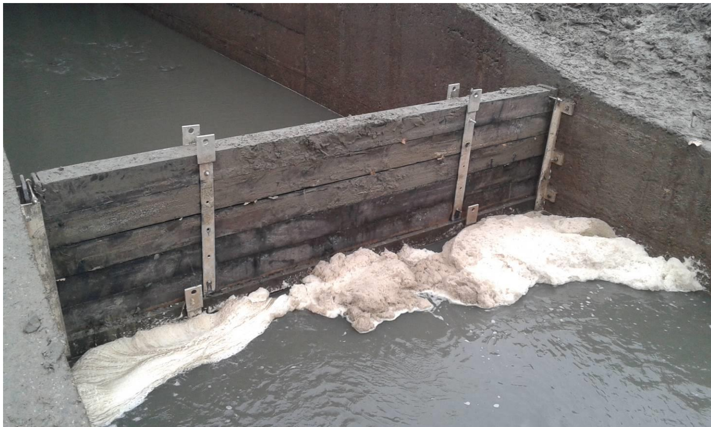
Obr. 23 Opatření proti splachu sedimentů do spodních výpustí, montované v roce 2013.
